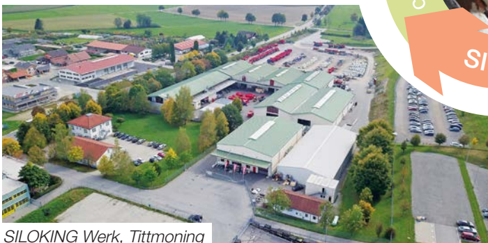
SILOKING Werk, Tittmoning
